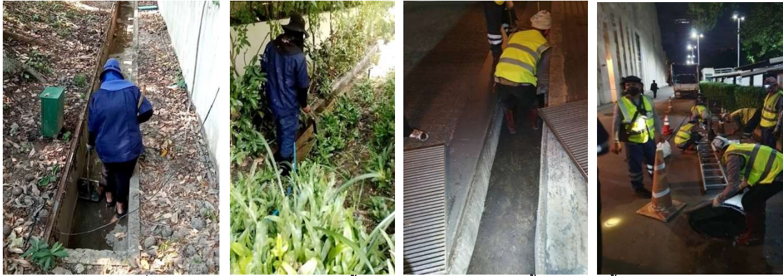
ภาพที่ 5-29 ตรวจสอบสภาพรางระบายน้ำไม่มี และขุดลอกรางระบายน้ำและบ่อพักน้ำอยู่เสมอ
