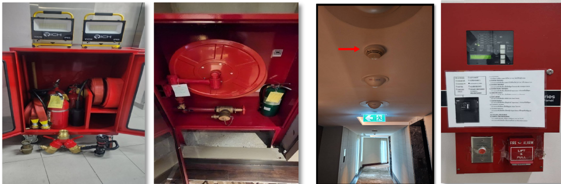
ตู้เก็บสายฉีดน้ำดับเพลิงพร้อมอุปกรณ์ ระบบท่อเย็น และสัญญาณแจ้งเตือนอัคคีภัย
