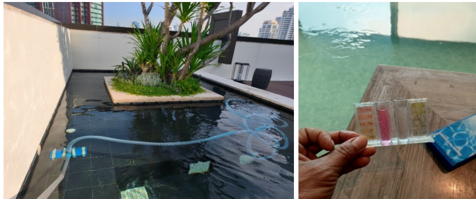
ภาพที่ 5-38 ดูแลรักษาสระว่ายน้ำ น้ำและตรวจวัดค่า pH , Chlorine Free เป็นประจำทุกวัน
