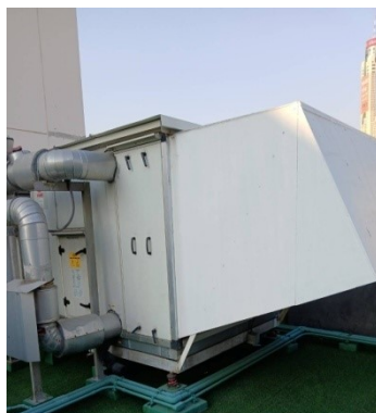
ภาพที่ 5-41 ตรวจสอบระบบการระบายอากาศประจำปี และล้างแผ่น PAU ทุกๆ 6 เดือน
