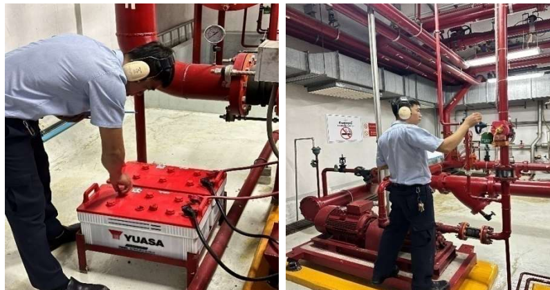
ภาพที่ 5-36 ตรวจสอบดูแลซ่อมบำรุงระบบสูบน้ำดับเพลิง (Fire Pump)
